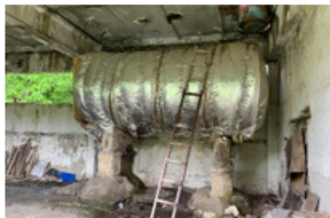
Fig. 8 Foto - Rezervor de apă alimentat de la Sonda Nr. 1288
