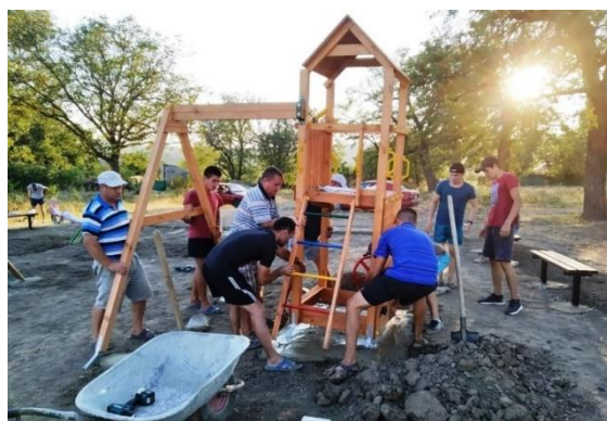
Figura 2. Instalarea unui teren de joacă în Capaclia
